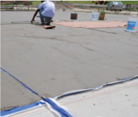
Vanntetting av underlag med Mapelastic og Mapeband
