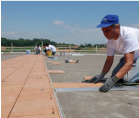
Legging av fliser med Kerabond + Isolastic
