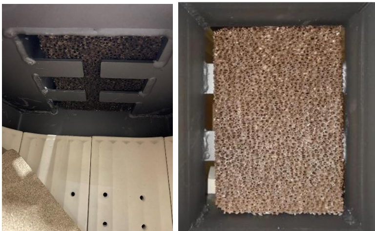
Katalysatormontering over kubbeholderen bak røykdeflektoren for M, Maestro, QM40 ecoline
